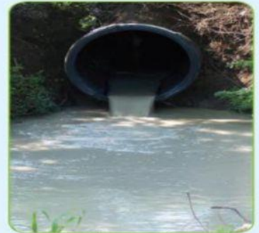
تصريف مياه الصرف الصحي
