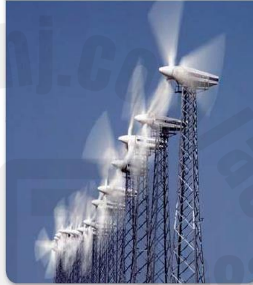
■ الشكل 22 تتحوّل طاقة الرياح إلى طاقة كهربائية عندما تُشغّل المروحة الدائرية المولّد.
