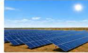
محطة الطاقة الشمسية
